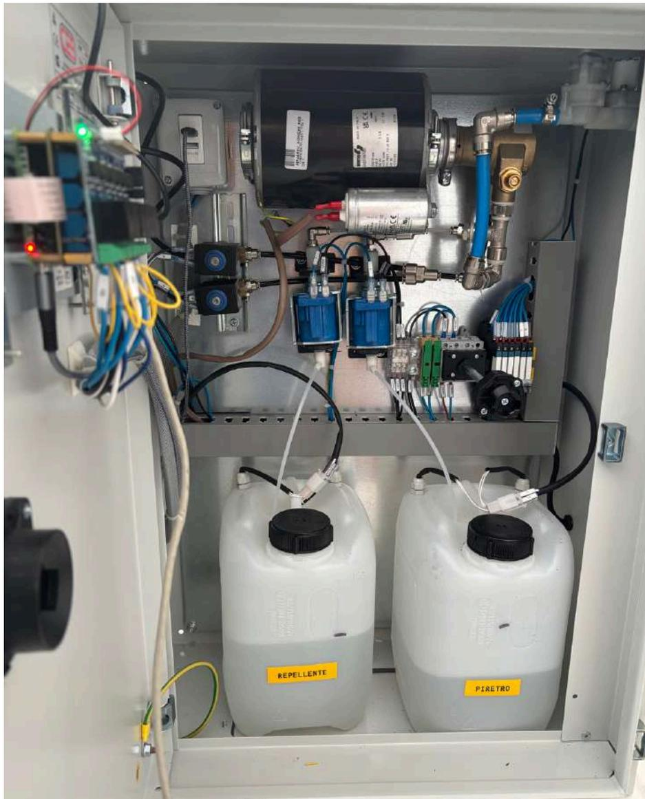
*Figura 5 - Zona "Q": circuito elettrico della centralina*
